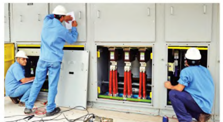
Instalando equipos de medición
